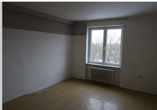
Pohled na část obýv. pokoje. ke kuchyni, kde byly dříve dveře
