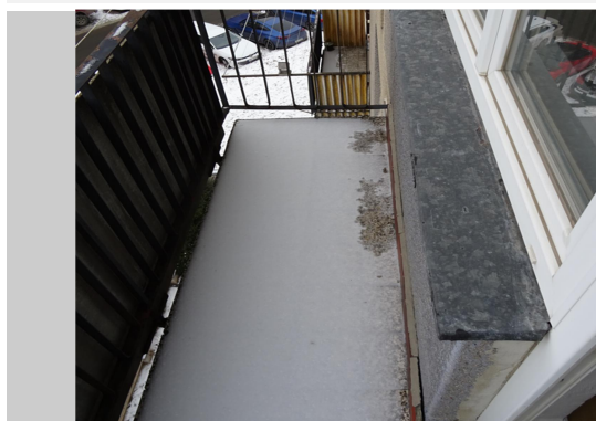
Pohled na balkon z chodby bytové jednotky
