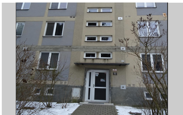
Pohled na vstup do budovy
